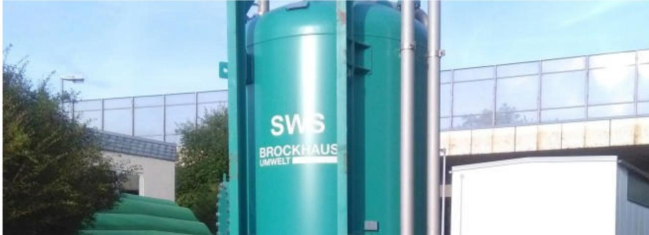
In der Kläranlage Kreuztal wird Aktivkohle eingesetzt
